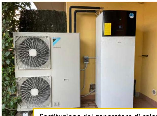
Sostituzione del generatore di calore associato all'impianto di climatizzazione invernale mediante **caldaia a condensazione** con un sistema a **pompa di calore**
