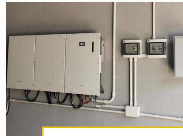
Installazione di un **sistema di accumulo** capacità **8kWh**
