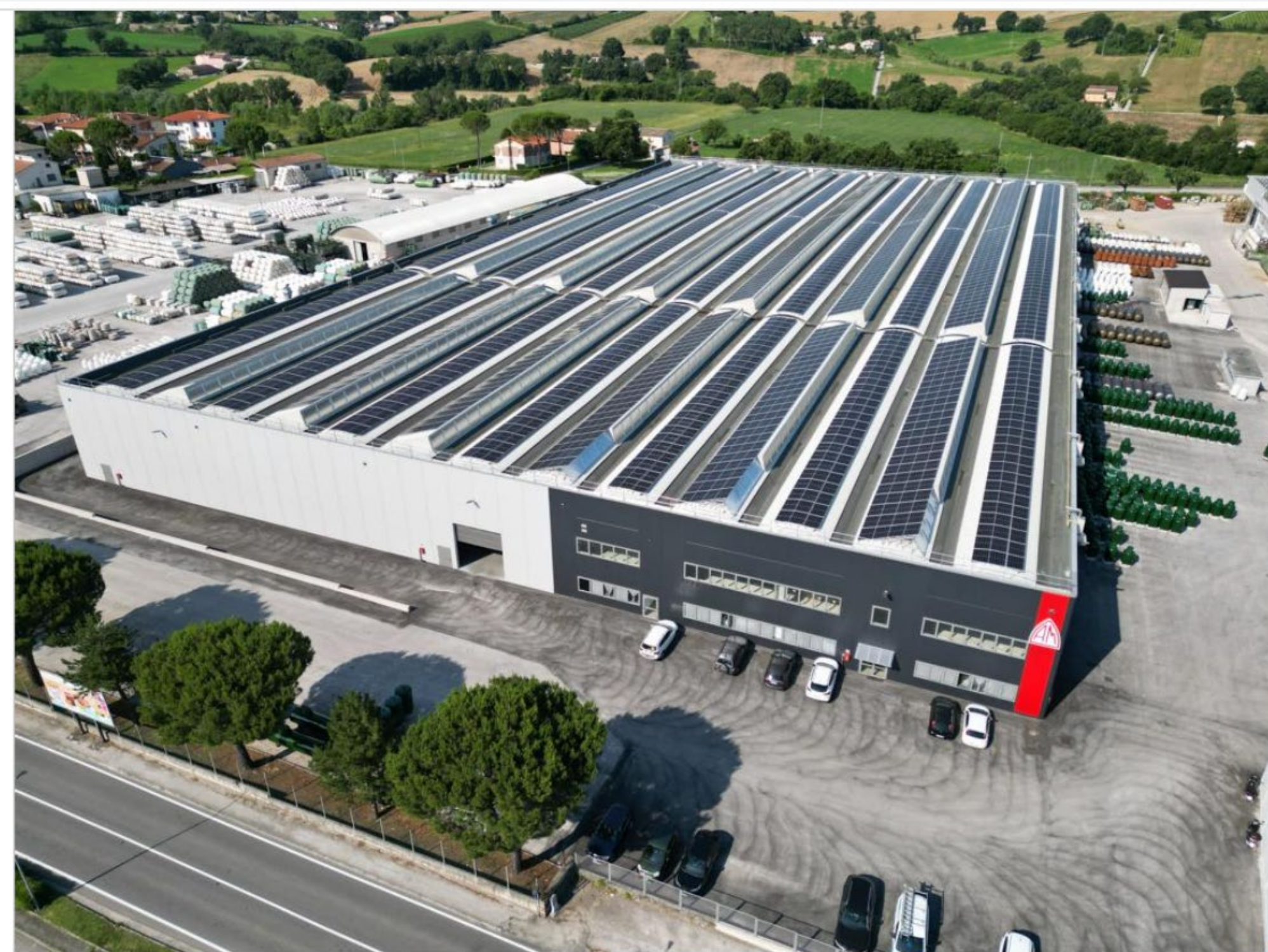
I pannelli fotovoltaici sopra al tetto dello stabilimento Antonio Merloni di Matelica
